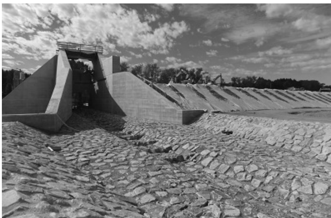
Abbildung 2: Bauzustand HRB Neuwürschnitz, Auslaufbauwerk, Tosmulde, Querriegel (ARGE HPI ARCADIS 10/2015)
