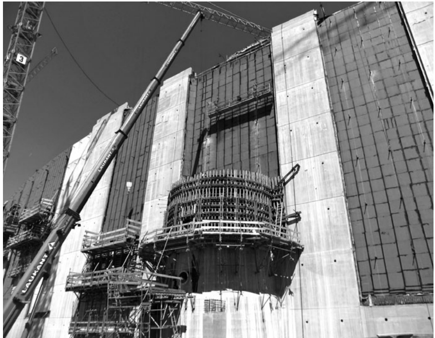
Bild 4: Herstellung Dichtwand und Entnahmeturm
