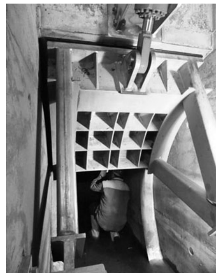
Bild 3: Drucksegmentschütz im Grundablass
