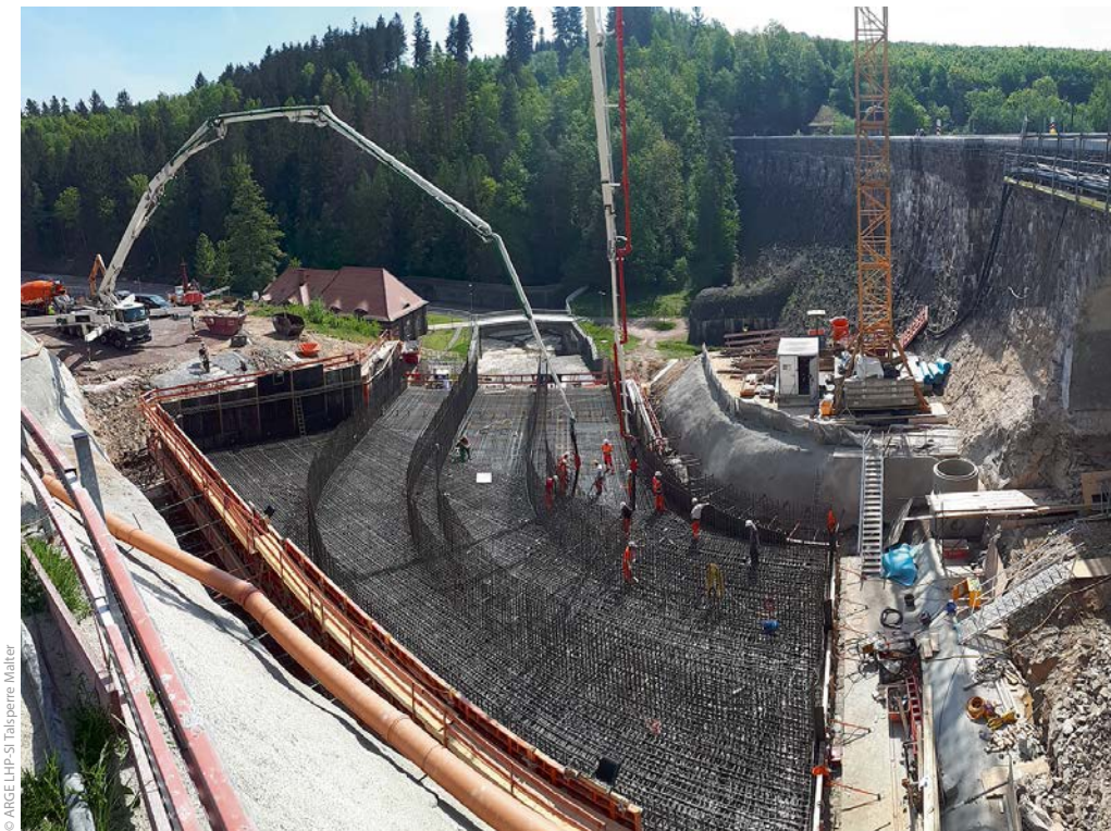
Bild 2: Bewehrungs- und Betonierarbeiten am Teilungsbauwerk
