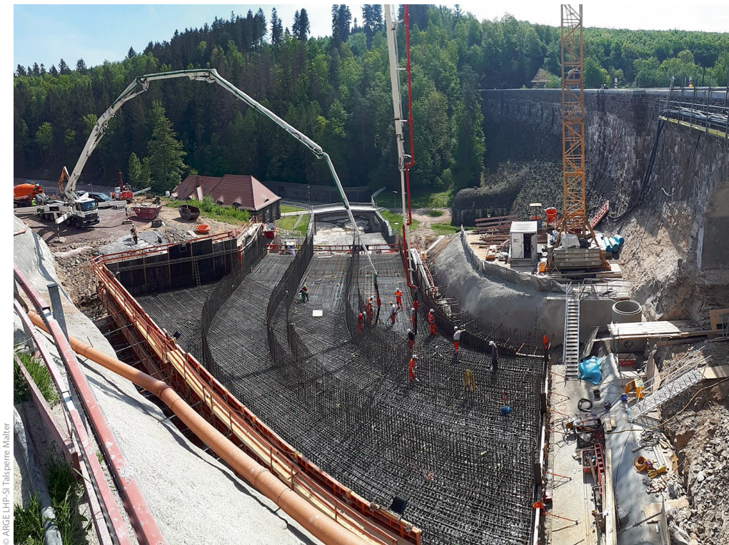
Bild 2: Bewehrungs- und Betonierarbeiten am Teilungsbauwerk
