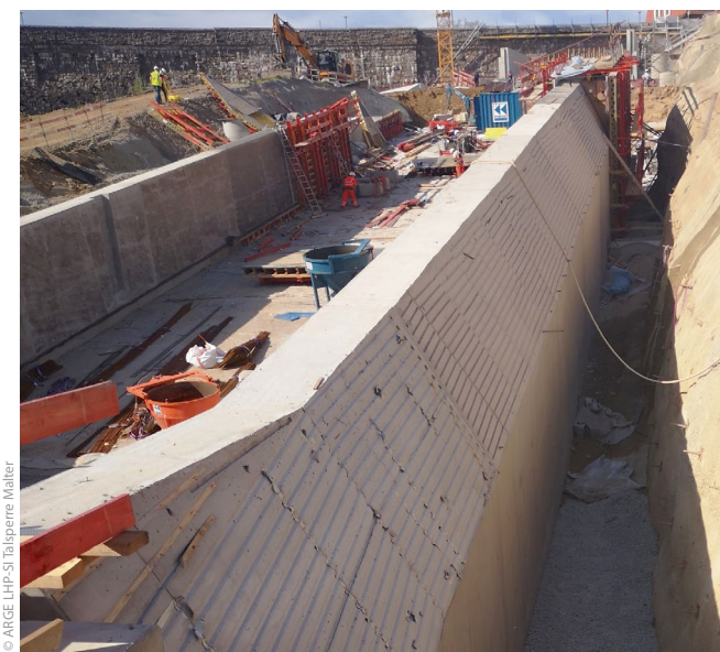
Bild 3: Unbewehrte Wände der Schussrinne
