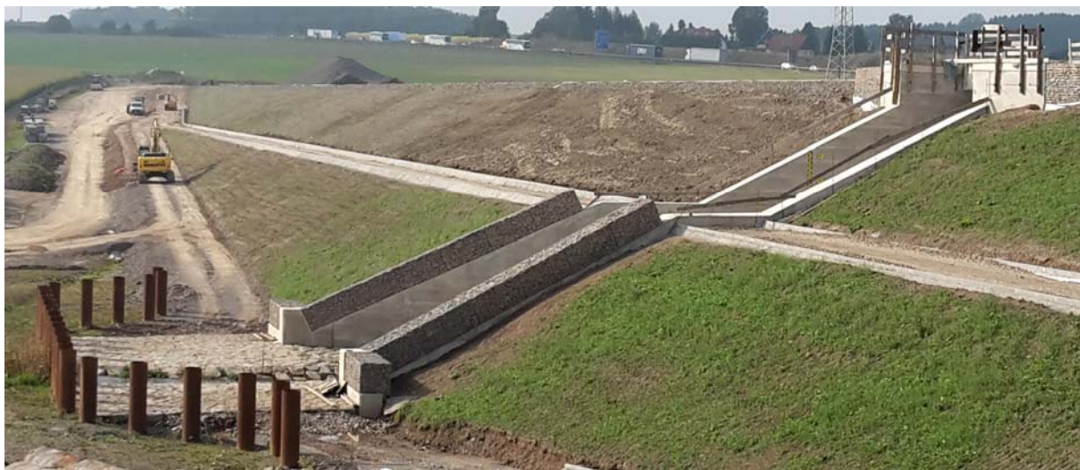
Abbildung 1: Absperrbauwerk Wasserseite mit Wildholzsperrre, Bauzustand 09/2016
