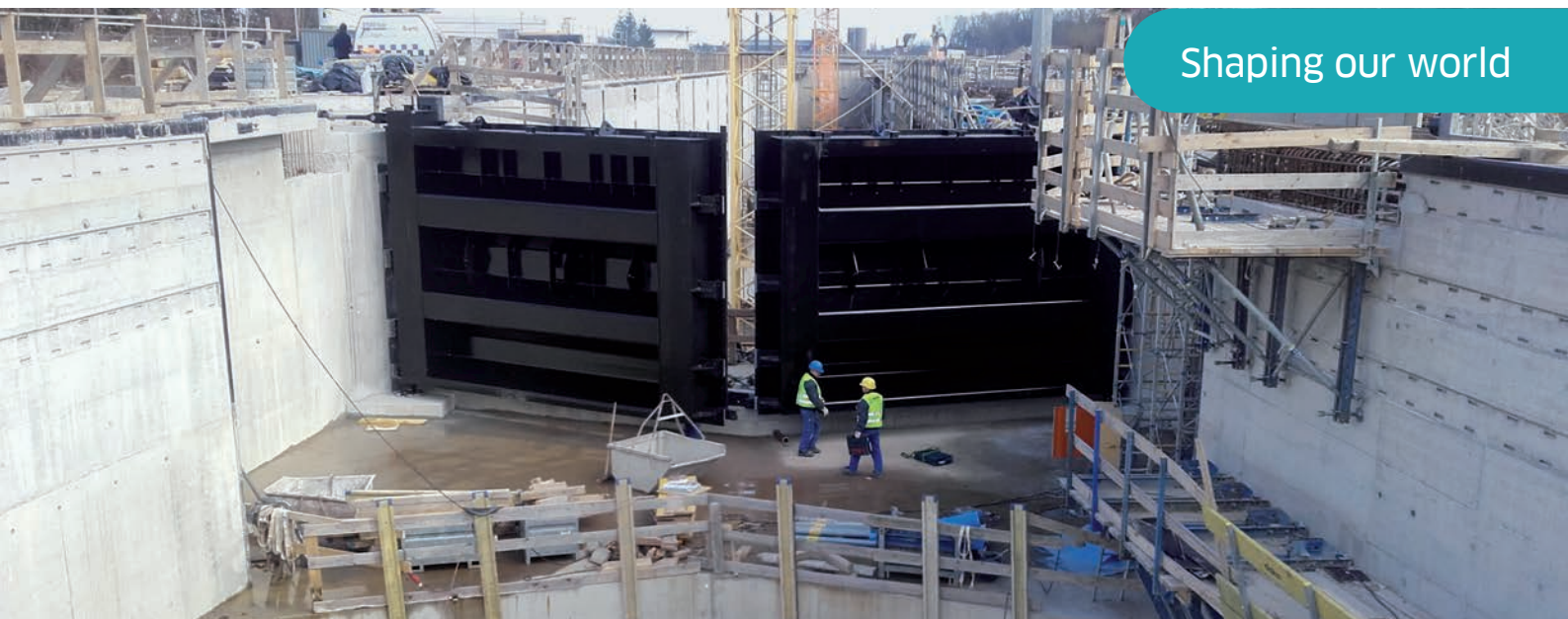
Einfahrtsbereich Schleusenammer Oberwasser
