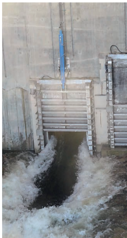
Durchströmung eines Gleitschützes
