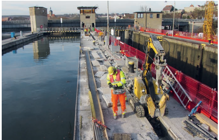
Abbrucharbeiten Kabelkanal Mittelmole
