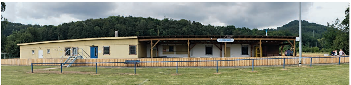
Vereinsheim mit holzverkleideter Hochwasserschutzwand
