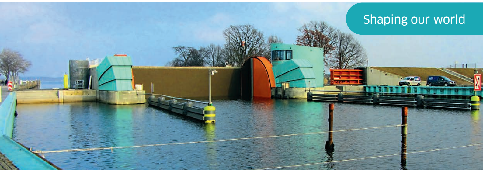
Sturmflutsperrwerk Greifswald-Wieck Richtung Dänische Wiek
