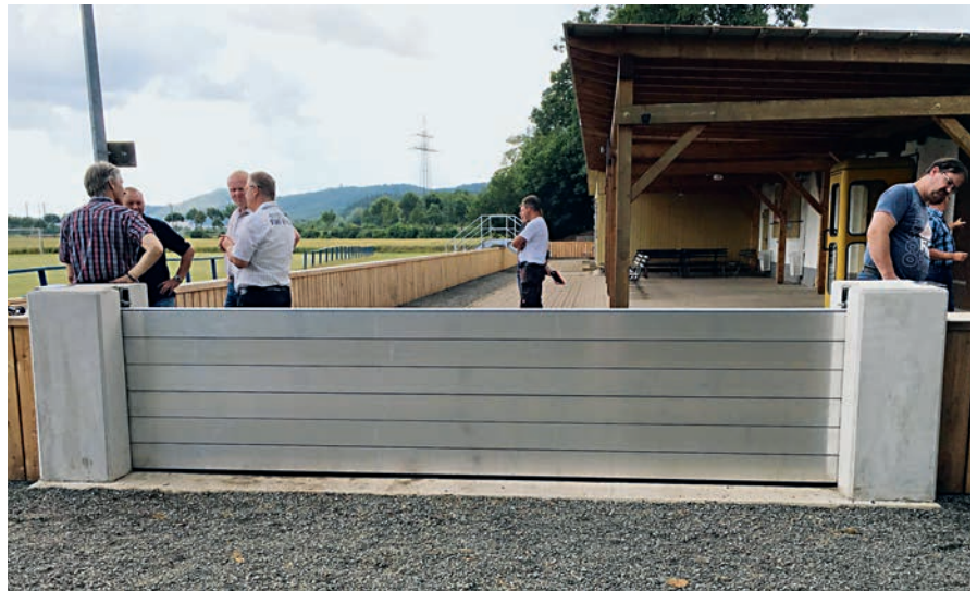
Detail holzverkleidete Hochwasserschutzwand mit Dammbalkenverschluss
