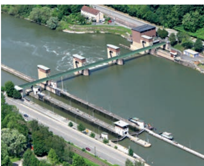
Schleuse Neckargemünd vor Baubeginn (Foto: WSV)
