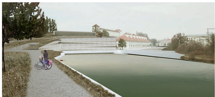
Kraftwerk Töging – Ansicht vom Bereich Unterwasser (Foto: Format Elf Architekten Töging)
