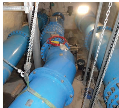
„Schwimmlotumfahrung“ DN 800 im Montagezustand
