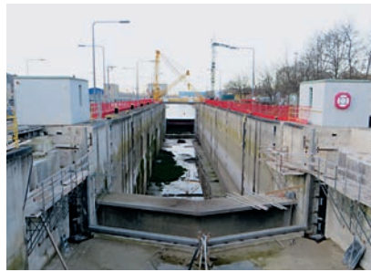
Schleuse Obertürkheim während der Bau-phase
