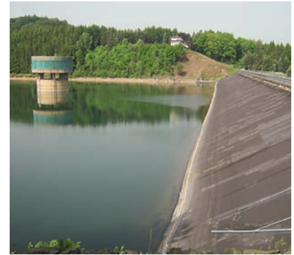
Komplexbauwerk und Absperrbauwerk der Talsperre Lichtenberg
