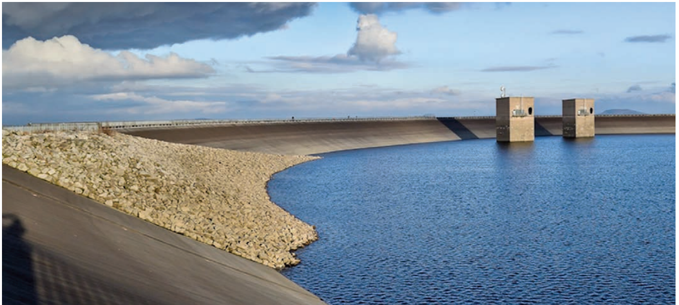
Ringdamm des Oberbeckens mit Einlauffürmen
