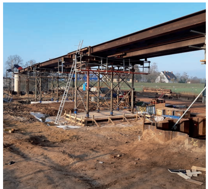
Traggerüstmontage oberhalb des Kraftwerksauslaufes
