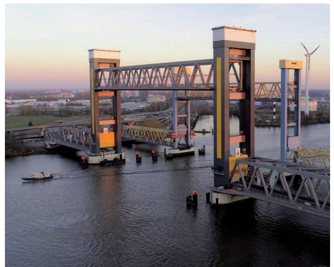
Neue und alte Kattwykbrücke
