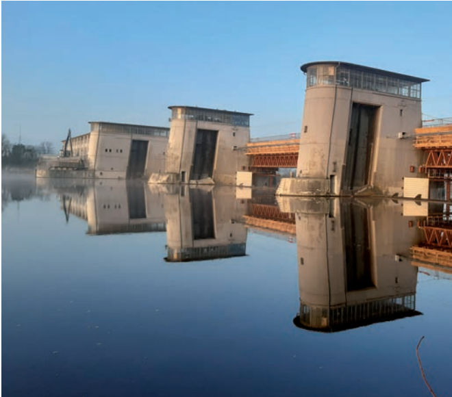
Bauwerk 57 mit Traggerüst im Bereich des Wehrüberlaufes
