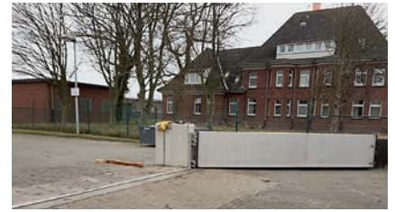
Montiertes Flutschutztor
