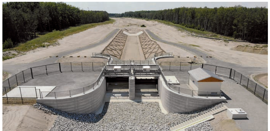
Luftbild Wehrbauwerk und gedichtetes Gerinne
