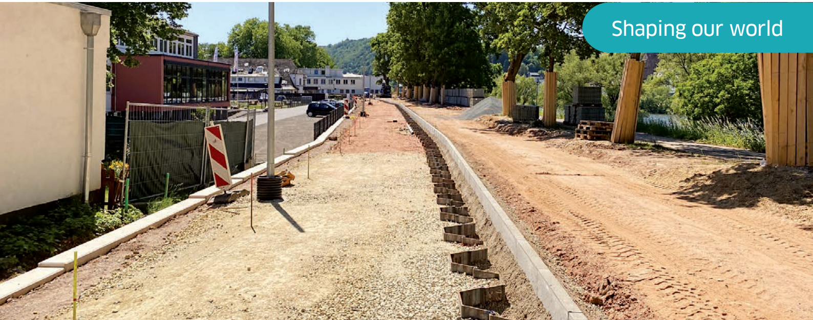
Spundwände unter dem Deichverteidigungsweg
