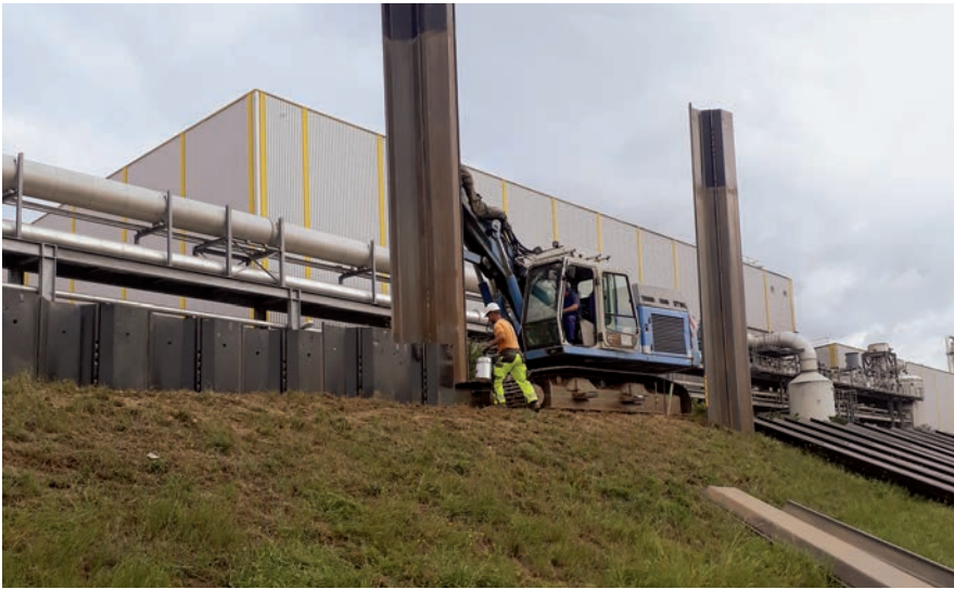
Einbau der Spundwände
