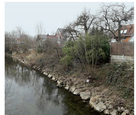
Ufernahe Bebauung in Ebersbach an der Fils
