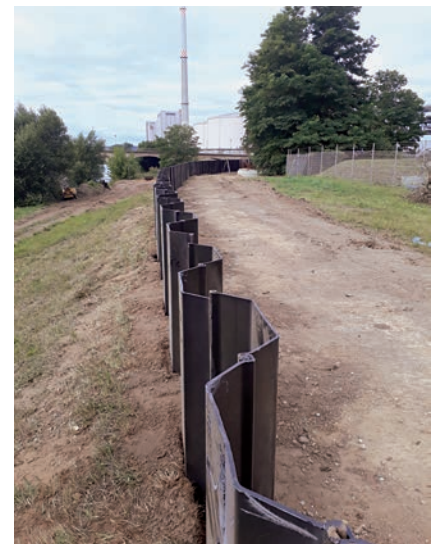
Eingebaute Spundwände
