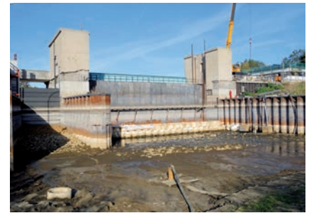
Baustelle des Altarmwehres (Quelle: WNA Magdeburg)
