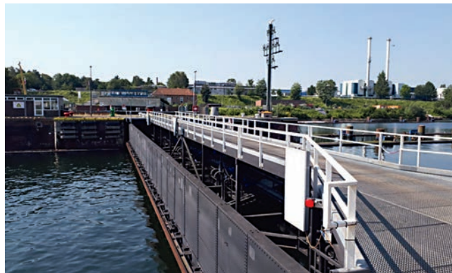
Ansicht Schleusentor Torkammer 1 Binnenhaupt
