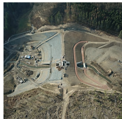
Das neue Absperrbauwerk
