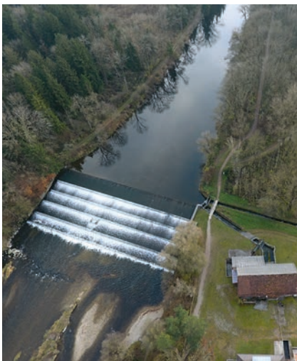
Wehr Türkheim und Ausleitung Langweidbach (© Bayerische Landeskraftwerke GmbH)
