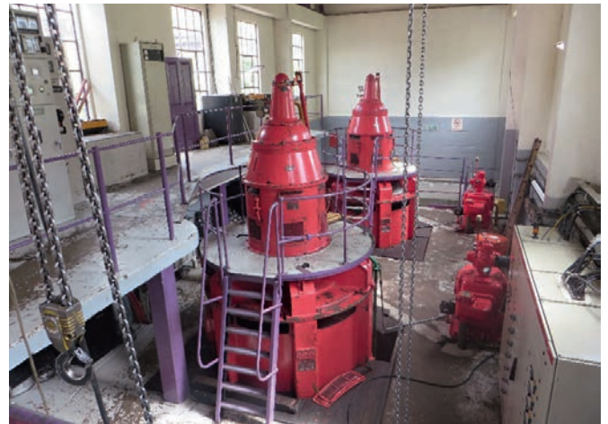
Innenansicht des Krafthauses
