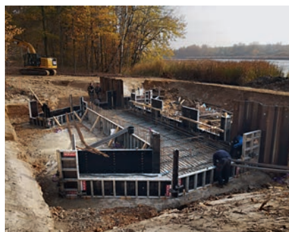
Schalungsarbeiten für die Hochwasserentlastungsanlage am Rodaer Damm
