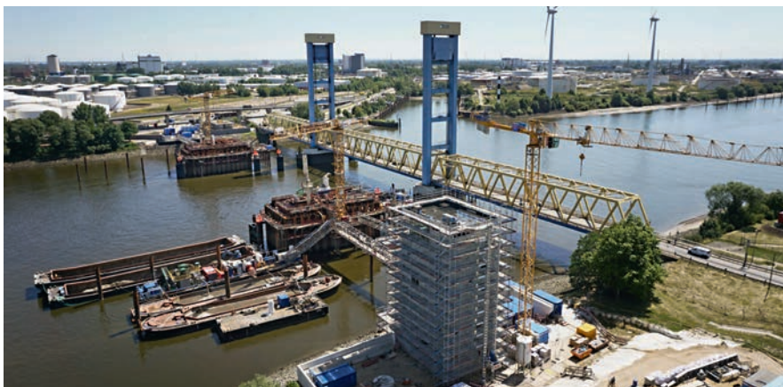
Stand der Bauarbeiten an der neuen Kattwykbrücke
