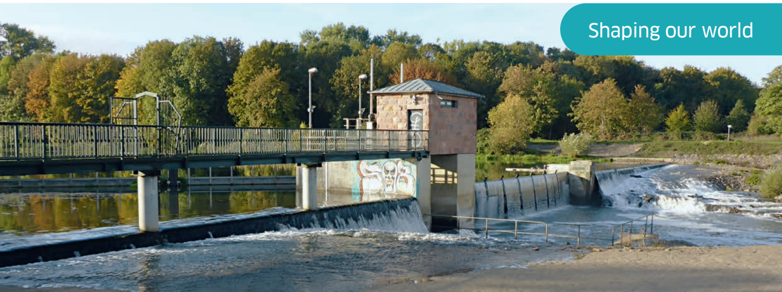
Das Luppewehr von Unterwasser während der Funktionsprobe
