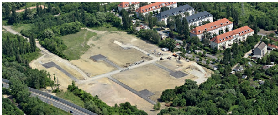
Stand der Erschließungsarbeiten des ersten Bauabschnittes im Sommer 2018
