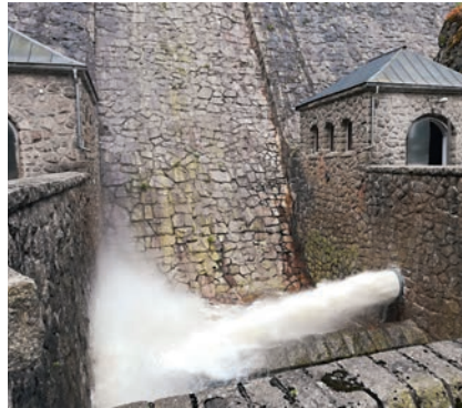
Auswurfstrahl aus dem linken Grundablass bei der Funktionsprüfung in das leere Tosbecken
