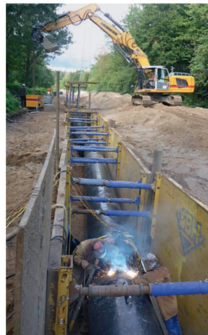
Verlegung der Leitung DN 1000 im verbauten Graben mit beidseitiger Fallnahtschweißung
