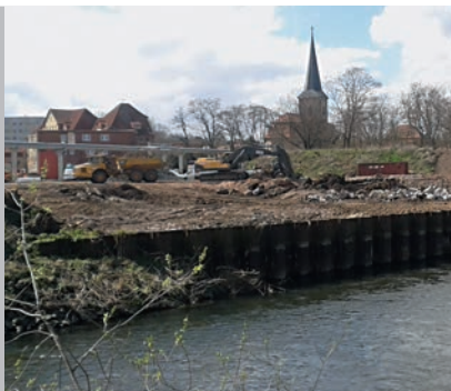
Blick auf den Baubereich bei Beginn des Aushubs für die Flussschlinge
