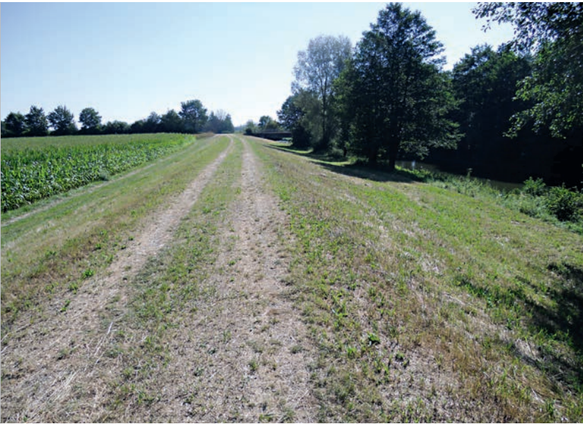
Bestehender linker Vilsdeich bei Mettenhausen, Blick flussabwärts
