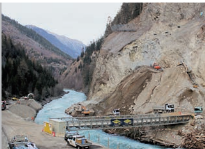
Baustelle der Wehranlage in Ovella
