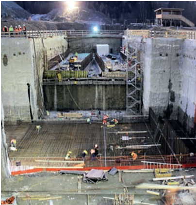
Baugrube für das Krafthaus in Prutz
