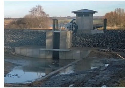
Blick auf das Absperrbauwerk mit Grundablass und Bedienhaus
