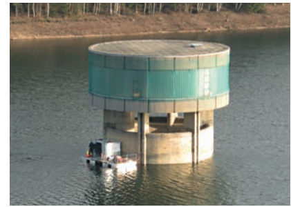
Entnahmeturm Komplexbauwerk während eines Tauchereinsatzes
