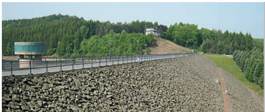
Luftseite des Steinschüttdammes
