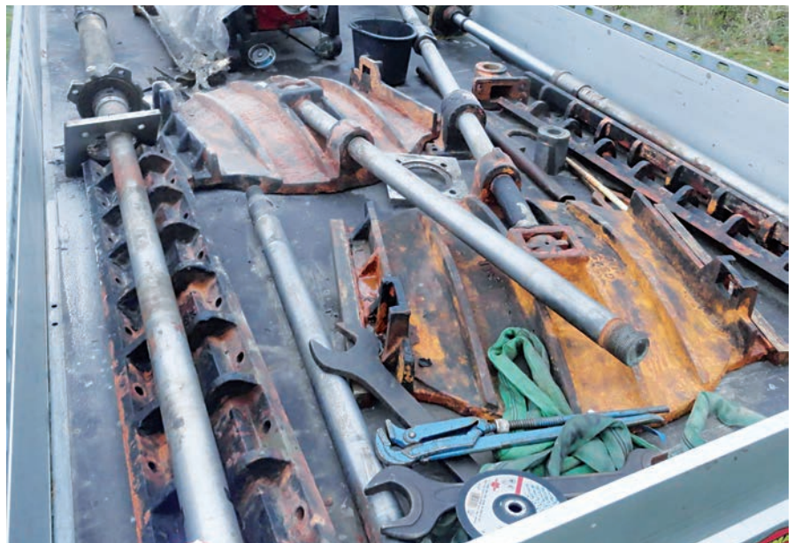
Wasserseitig demontierte Teile der Talsperrenschieber: Schieberplatte, Antriebsgestänge und Führungsbahnen
