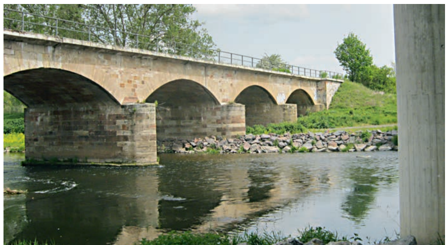
Nördliche Planungsgrenze Eisenbahnbrücke Bad Köstritz
