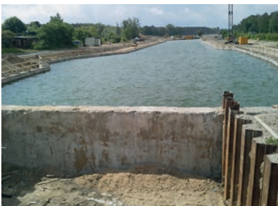
Mit Wasser gefüllte Baugrube der Schleusenkammer
