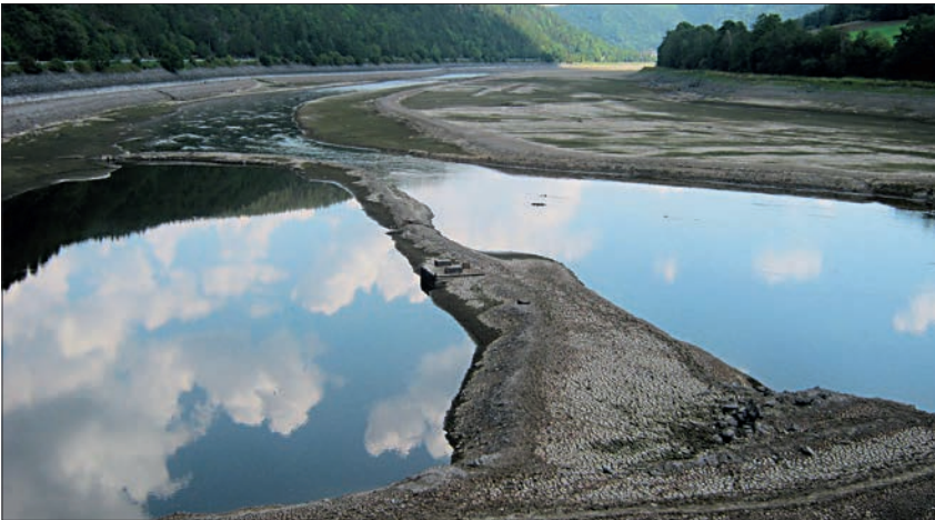
Blick über das abgesenkte Staubecken der Talsperre Eichicht
