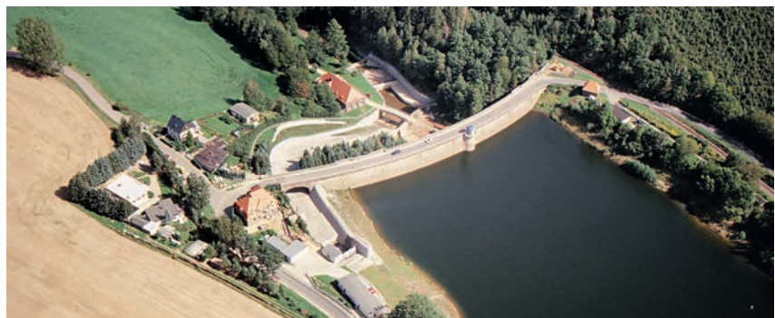
Gesamtansicht der Stauanlage
