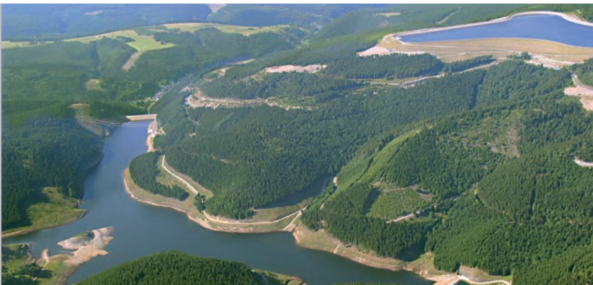
Gesamtansicht der Anlage (© Vattenfall)
