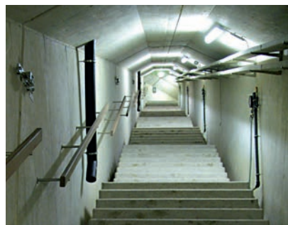
Kontrollgang Hauptsperre mit Sohlwasserdruckgeber (rechts) und Fissurometer (links)
