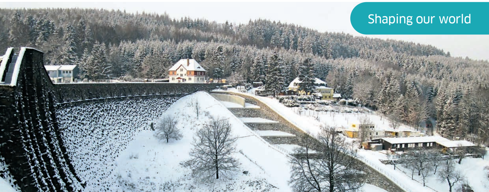
Ein Großprojekt: Die Sanierung der Talsperre Klingenberg im Freistaat Sachsen
