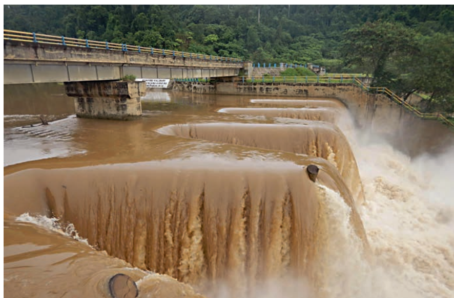
Bestehende Wehranlage am Kalibumi
