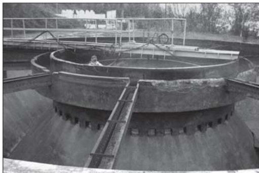
Bestand: Flokkulator Nr. 1 bei Reinigungsarbeiten
