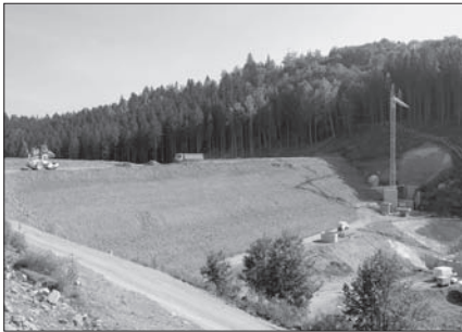
Dammschüttung Ende September
