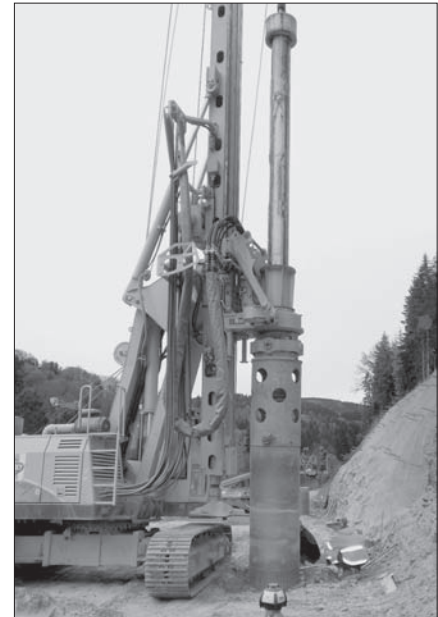
Bohrarbeiten für die Bohrpfahlgründung der Stützmauer
